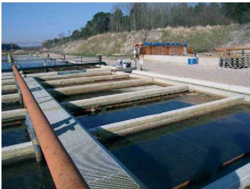
Figur 20. Biofilter med bioblokke opdelt i sektioner på Ejstrupholm modeldambrug type 3. Til højre for biofiltret ses et okker anlæg, hvor der sker en beluftning af indtagsvand og bundfældning af okker før vandet ledes ind i produktionsanlægget. Foto: Alfred Jokumsen.
