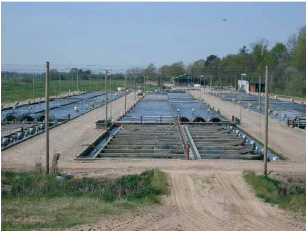
Figur 14. Kongeåens modeldambrug type 3. Produktionsenhederne omfatter 3 sektioner, der hver består af 2 beton raceways med mikrosigter (maskestørrelse 74 µm) foran biofilter sektionerne (forgrunden). I baggrunden til venstre ses plantelagunerne bestående af de tidligere jorddamme og indløbs- og udløbskanaler (Svendsen et al., 2008). Foto: Lars M. Svendsen.
