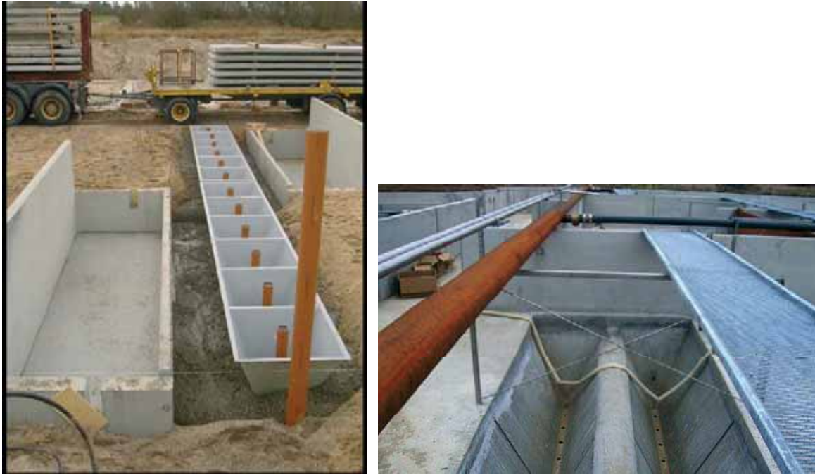
Figur 17. Slamkegler er placeret nedstrøms i hver raceway sektion i fuld bredde af bassinet og i niveau med bassinbunden. Til venstre har hver raceway 6 separate slamkegler, mens bassinet til højre har én slamrende i dets fulde bredde med kun et afløb. Foto: Lars M. Svendsen og Lisbeth J. Plesner.
